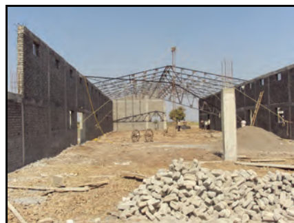
Figure 4 : Usine de production de panneaux de particules en construction à Washim, Inde
