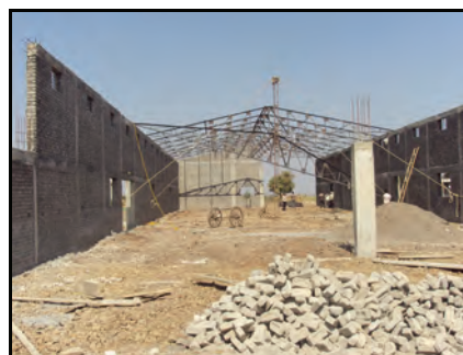
Figura 5: Planta de tableros de partículas en construcción en Washim, India
